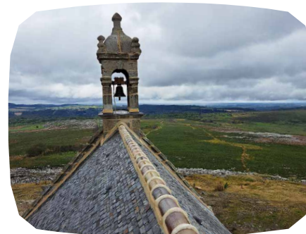
Restauration des tuiles faitières © Coadou couverture
